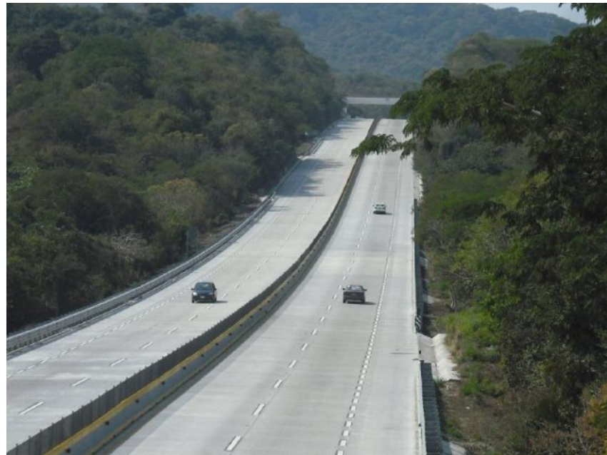
Pavimento mediante losas de concreto hidráulico, Autopista Cuernavaca-Acapulco
