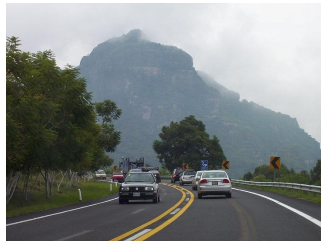
Autopista La Pera-Cuautla
