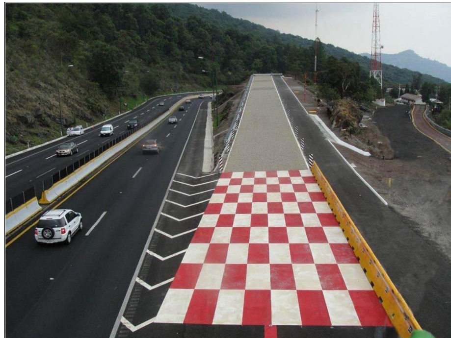
Rampa de Emergencia, Autopista México-Cuernavaca
