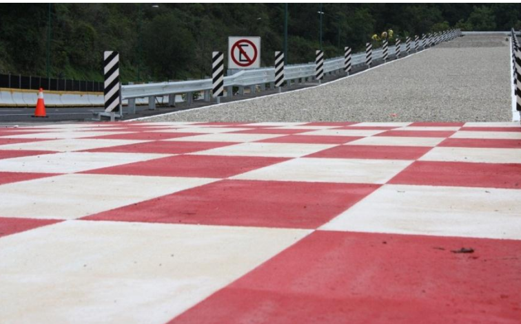
Rampa de emergencia, Autopista México-Cuemavaca
